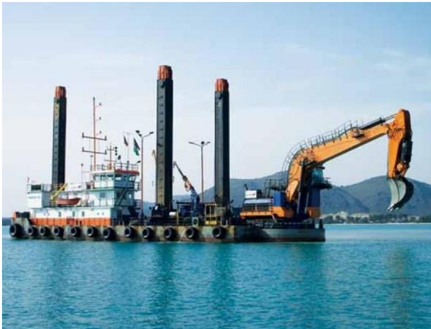
Image: Andy May, Van Oord Australia Pty Ltd.
